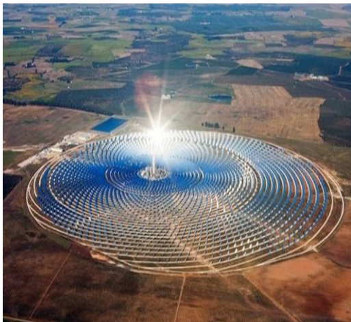
Figure I. 2 : Centrales électriques thermiques solaires (miroirs plans).
