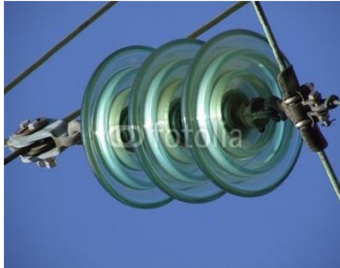
Figure I. 3: Chaine d'isolateur.
