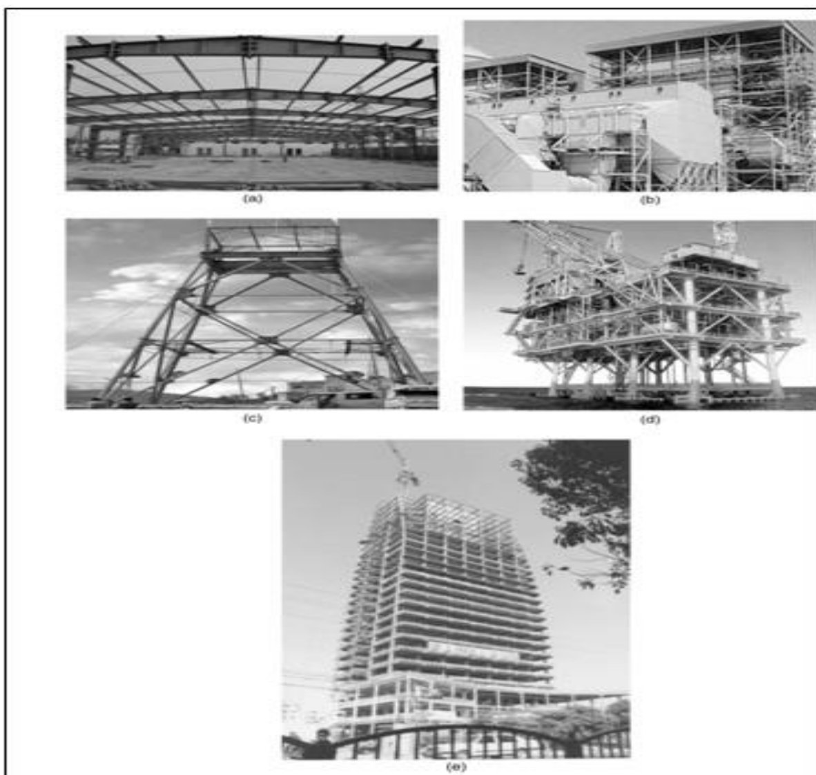
Figure II.0 6: application des charpentes en acier: (a) bâtiment industriel à un étage: (b) centrale électrique: (c) tour des mineurs de minerai: (d) plate-forme de distribution de pétrole et de gaz: (e) immeuble de grande hauteur
