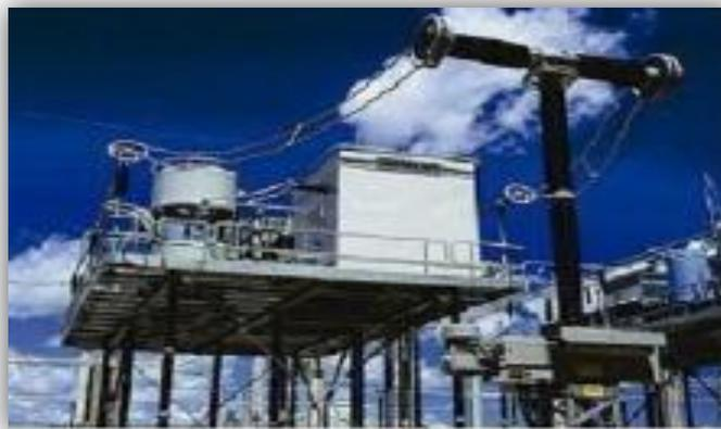
Fig. II.2 : Exemple réel d'un TCSC [11].
