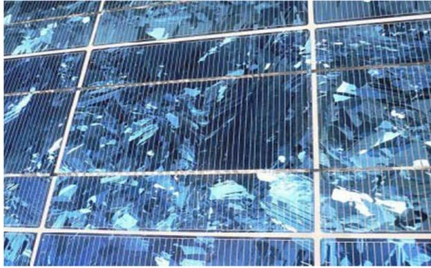
Fig. I.7: Panneaux PV avec cellule poly cristallines
