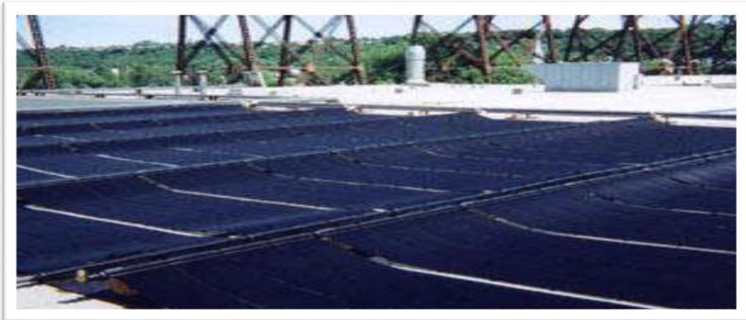
*Figure I. 4: Capteurs solaires sans vitrage [2].*
