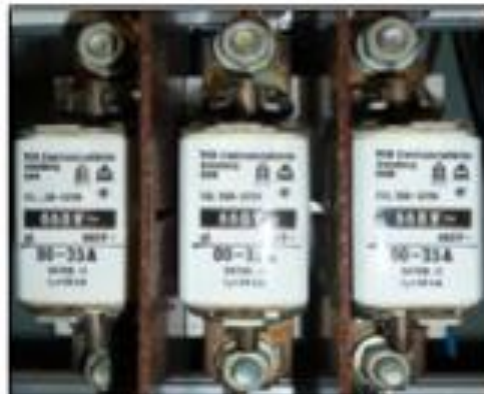
Figure I.7. Barrière entre 3phases basse tension [12].
