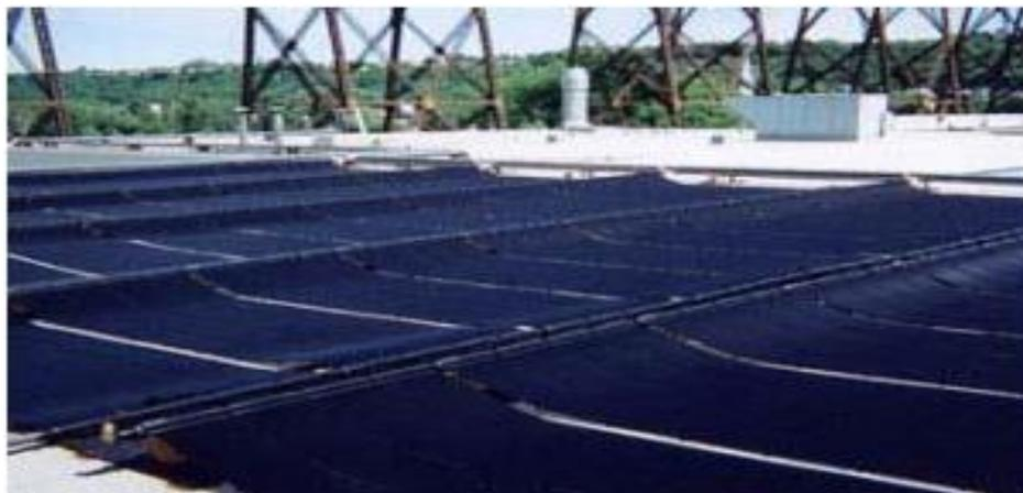
FIGURE I-4 : CAPTEURS PLANS SANS VITRAGE
