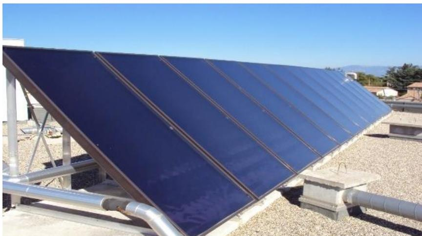
**FIGURE 1-1 : CAPTEUR SOLAIRE PLAN**
