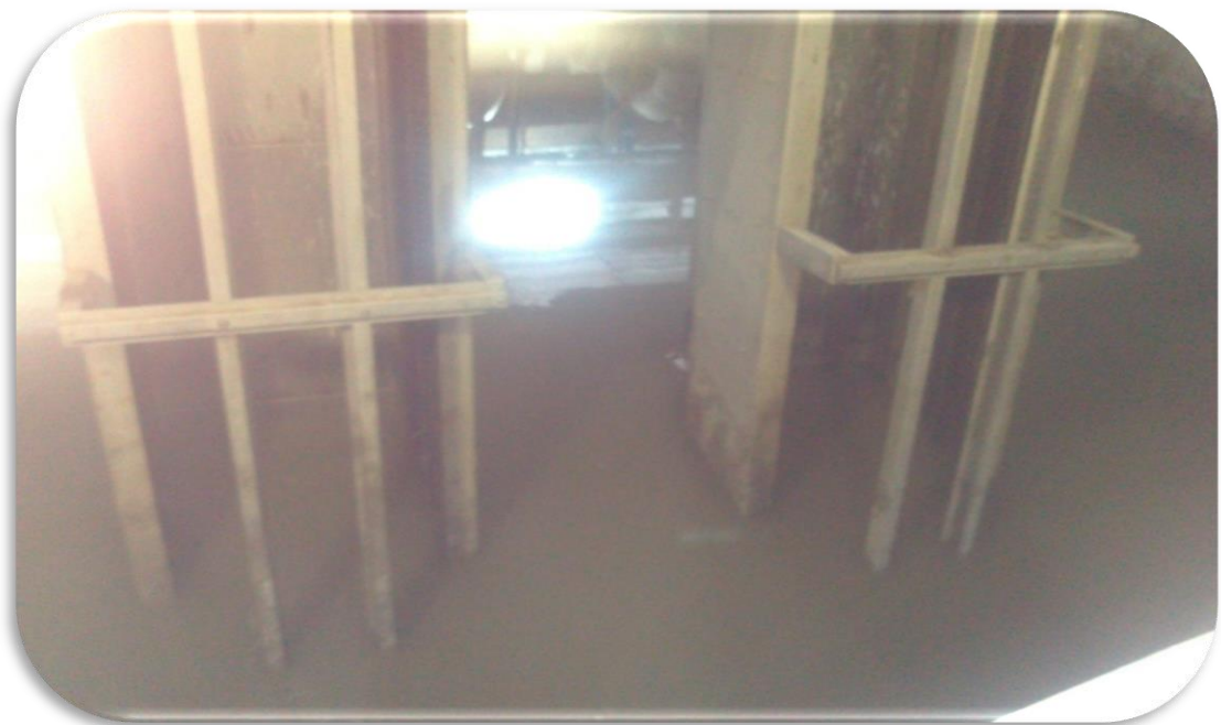
Figure I.7 : Dégrilleur gros.
