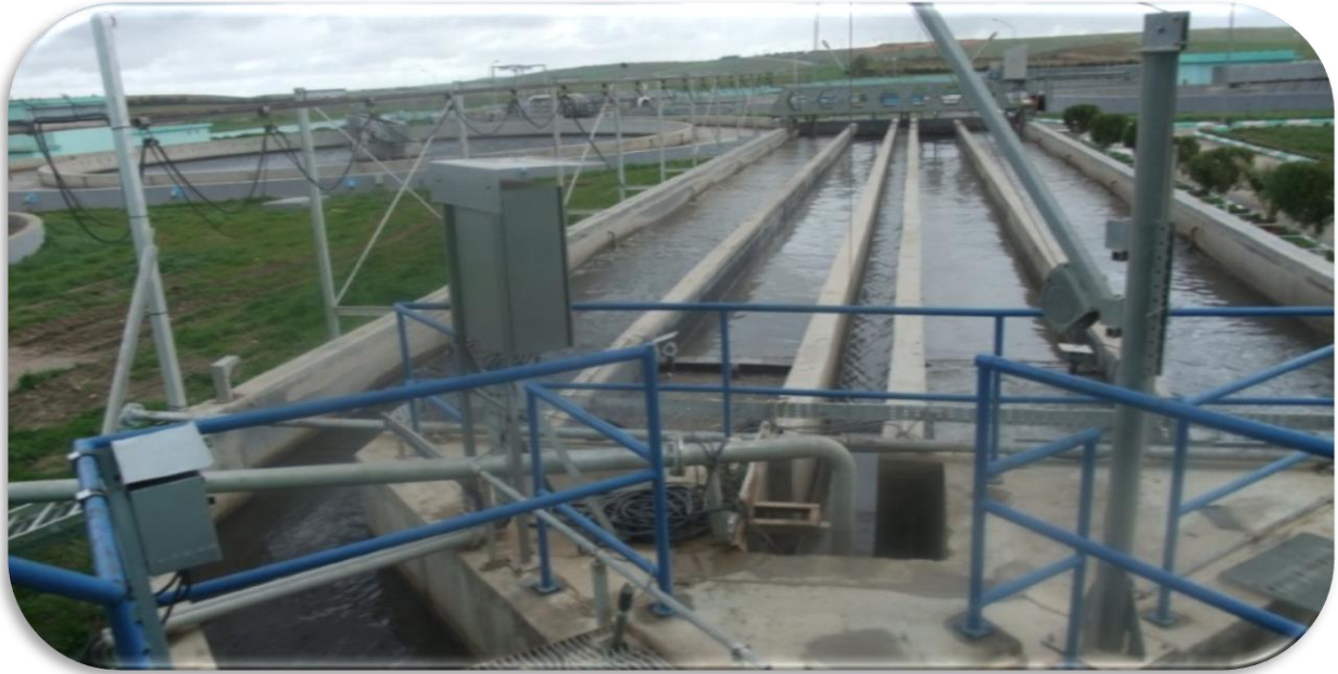
Figure I.9 : Désuilage et dessablage.
