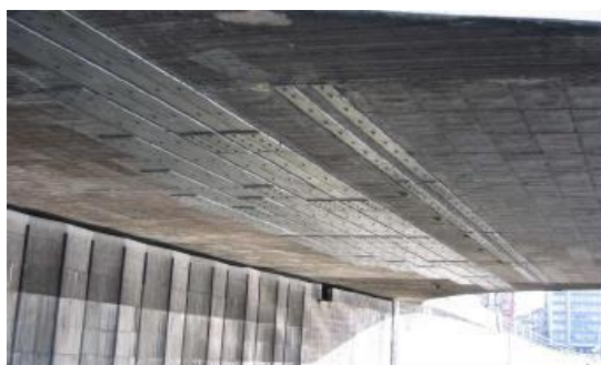
Figure I. 8: Renforcement par plats métalliques
