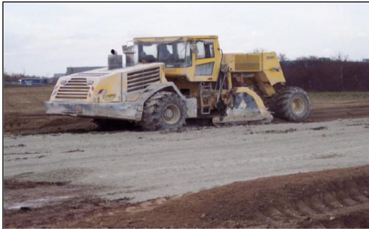
Figure 2.7: Chantier de traitement du sol au ciment.
