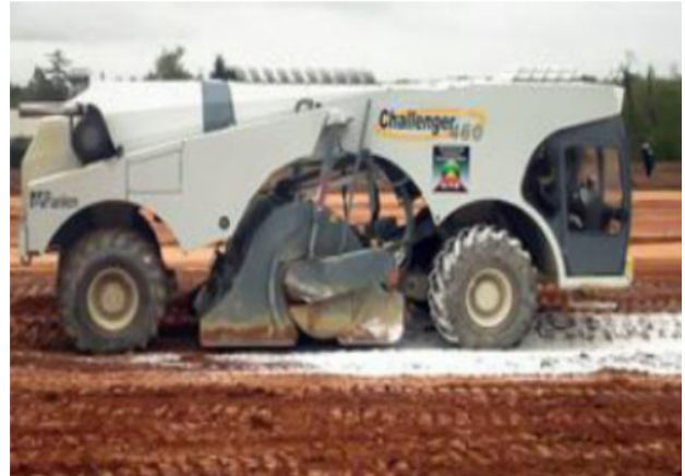
Figure 2.9: Chantier de traitement d'un sol à la chaux (France, 2009).
