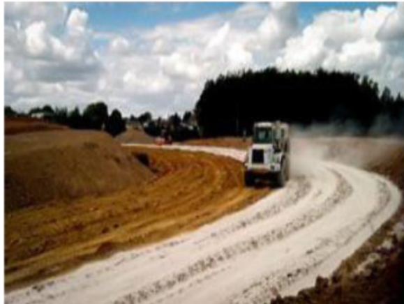
Figure 2.9: Chantier de traitement d'un sol à la chaux (France, 2009).
