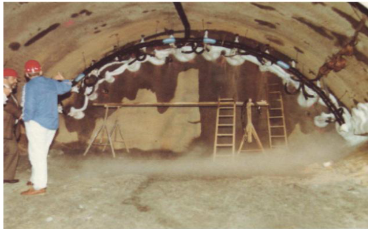
Figure 2.6: Traitement par congélation à Nice d'une zone sous chaussée traversée en tunnel et à Vienne sous bâtiment pour tunnel de métro.
