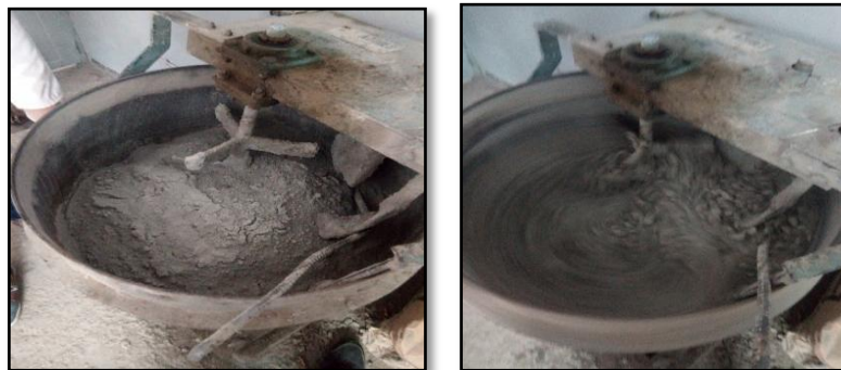
Figure VI.31: Malaxage du béton réalisé
