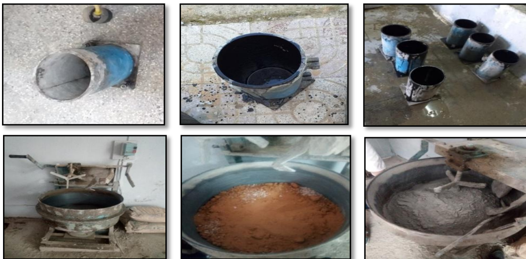
Figure VI.28: Préparation des épreuves de béton (lubrification des moules)
