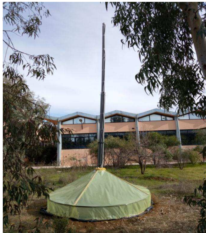
Figure.3.1. Photographie de la station solaire a effet cheminée.
