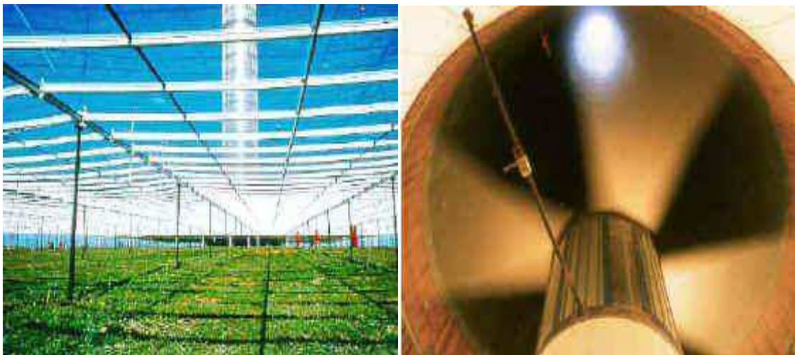
Figure (2.10) : Vues de la turbine dans la tour et sous la serre. [46]
