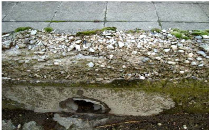
Figure I.6 : Effet de Gel-Dégel.
