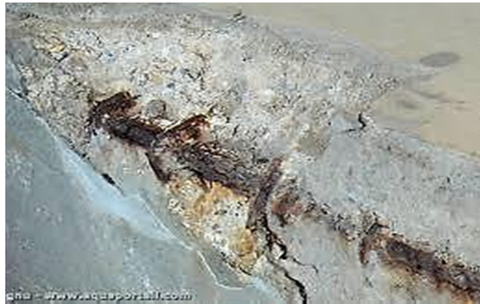
Figure I.2 : Carbonatation des bétons.
