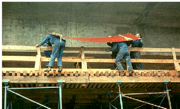
Figure II.5 : Tôles collées difficulté de manutention perforées -Brevet Freyssinet[19].
