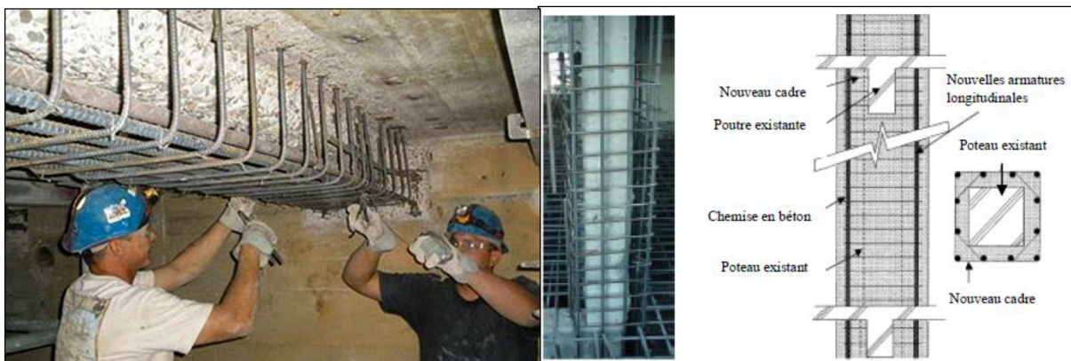
Figure II.1 : Chemisage en béton armé.
