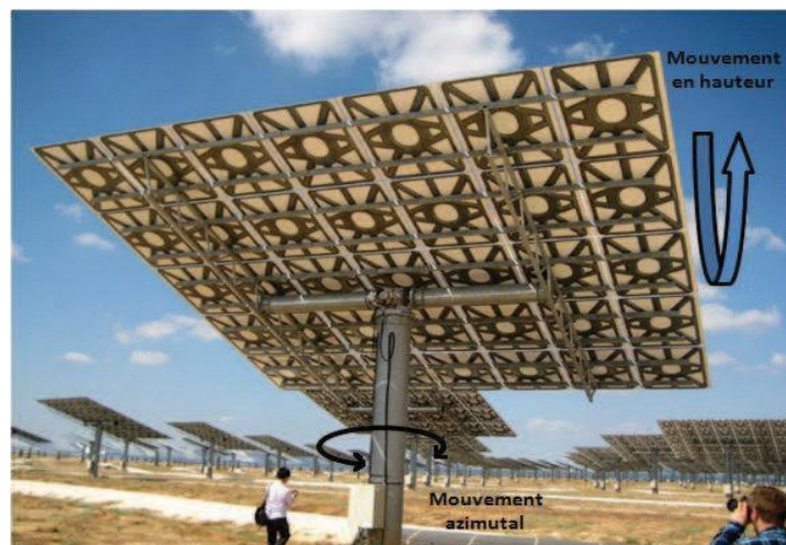
Figure III.5. Le mouvement d'un héliostat ayant une monture altazimutale
