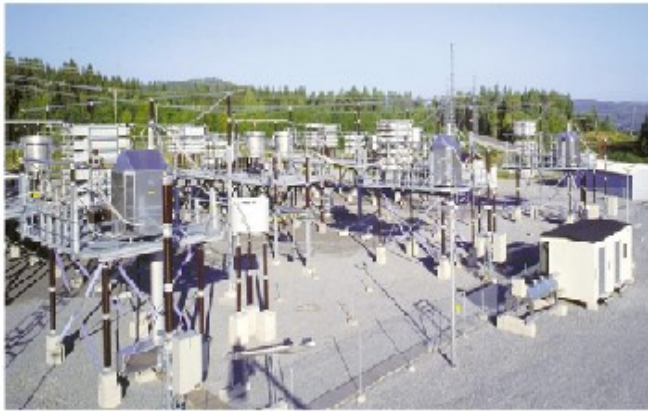
Figure III.12. : Exemple réel d'un TCSC.
