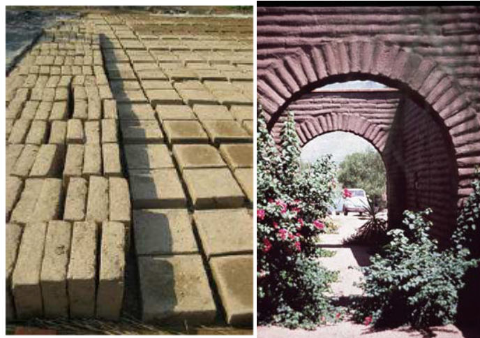
Figure 2: A gauche : des adobes au séchage sous le soleil. A droite : une maçonnerie en adobes.
