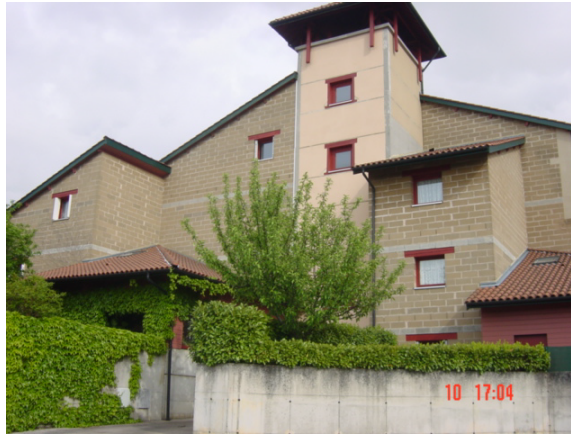
Figure I.3: Une maison construite avec des BTC en Rhône-Alpes, France. La tour est en pisé.
