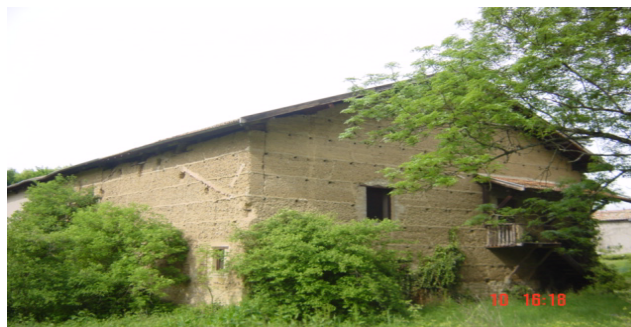
Figure I.1: Une maison traditionnelle en pisé en région Rhône-Alpes, n'ayant jamais été enduite.
