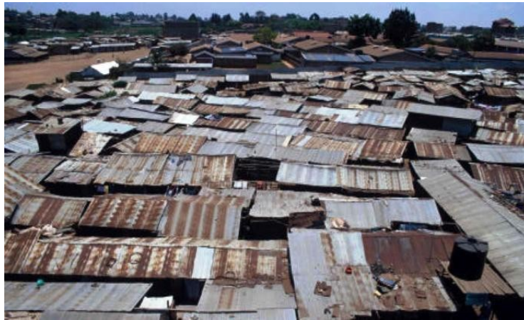
Figure 12: Etat des constructions dans les bidonvilles
