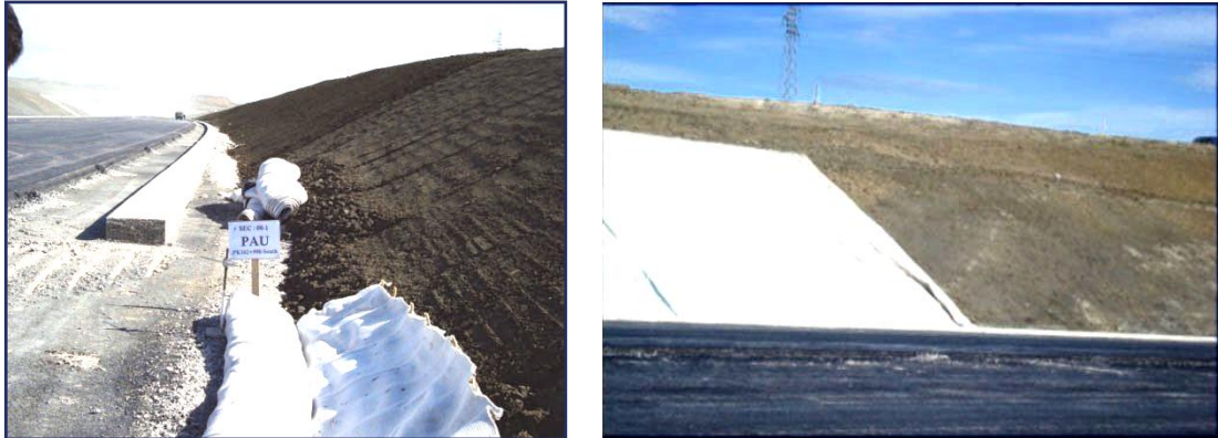
Figure V.4. Mise en œuvre du géocomposite de drainage.
