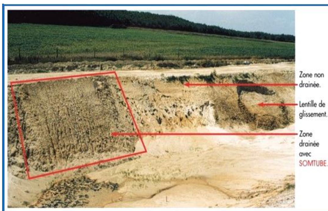
Figure V.3 Comparaison avec ou sans géocomposite sur talus.
