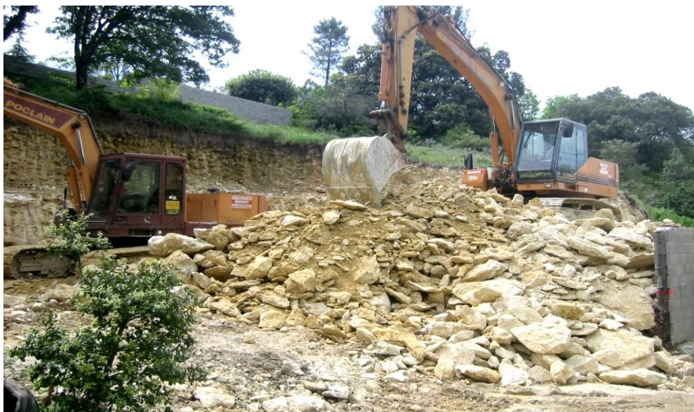
Figure V.9: Travaux de terrassement
