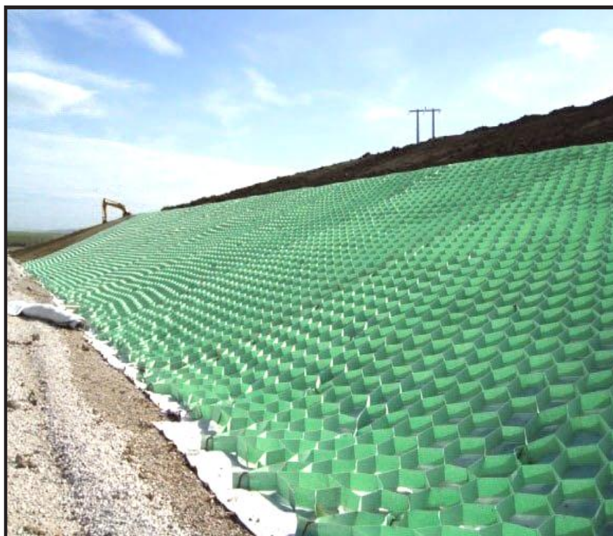
Figure V.7 Le géosynthétique mis en œuvre.
