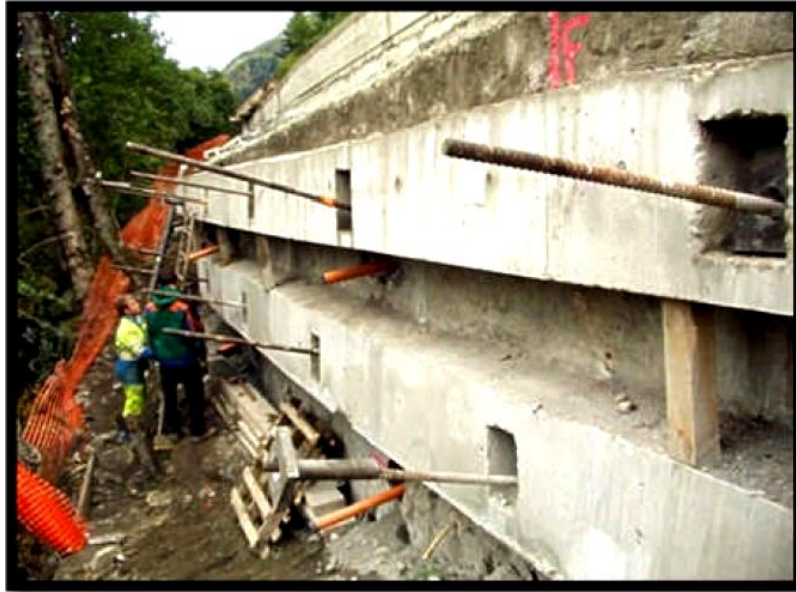
Figure IV.15: Renforcement par ancrage
