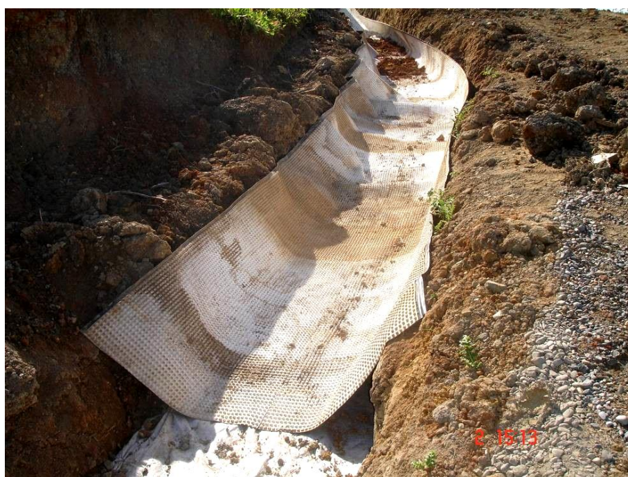
Figure V.15. Mise en œuvre du géocomposite étanche
