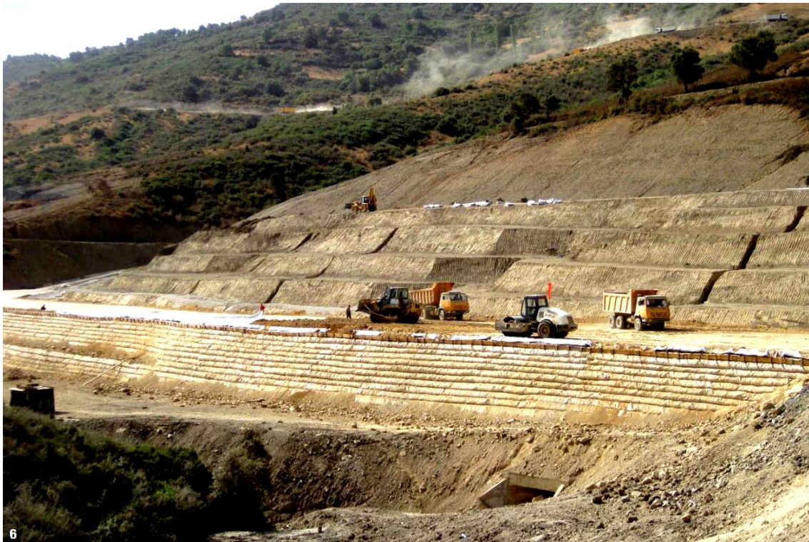
Photo V.2: Stabilité du talus par terrassement de banquettes « autoroute est ouest »
