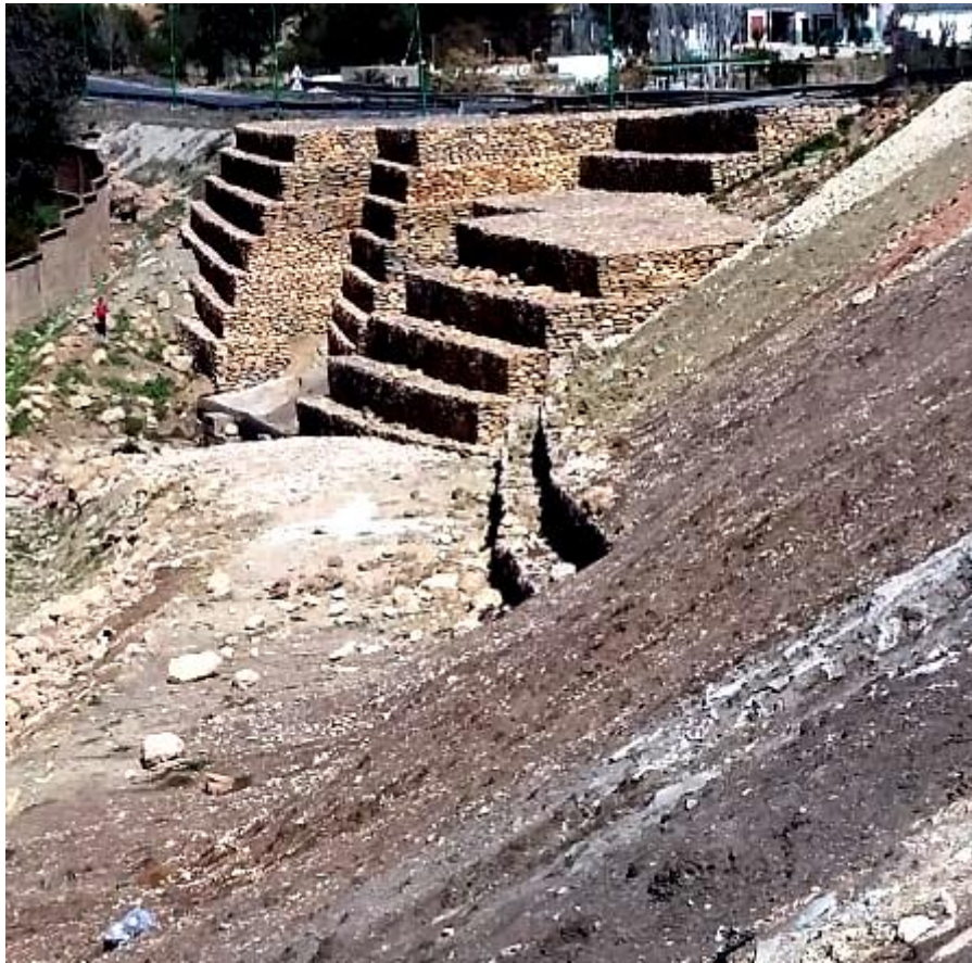
Photo V.6 : Protection du talus de la route par système de gabionnage « TIARET »
