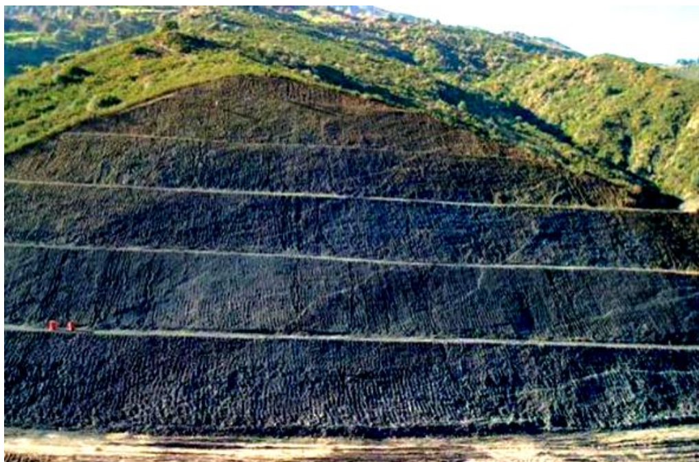
Photo V.1 : Stabilité du talus par terrassement de banquettes « autoroute est ouest »
