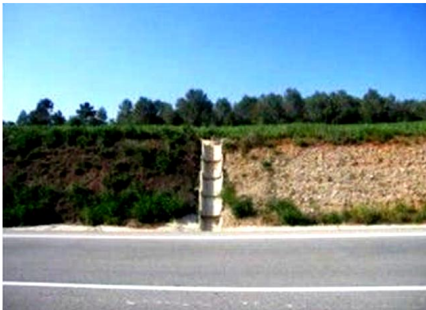
Figure V5 : Exemple de drainage
