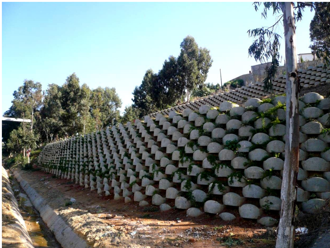
Figure V.18 Ouvrage achevé avec la végétalisation
