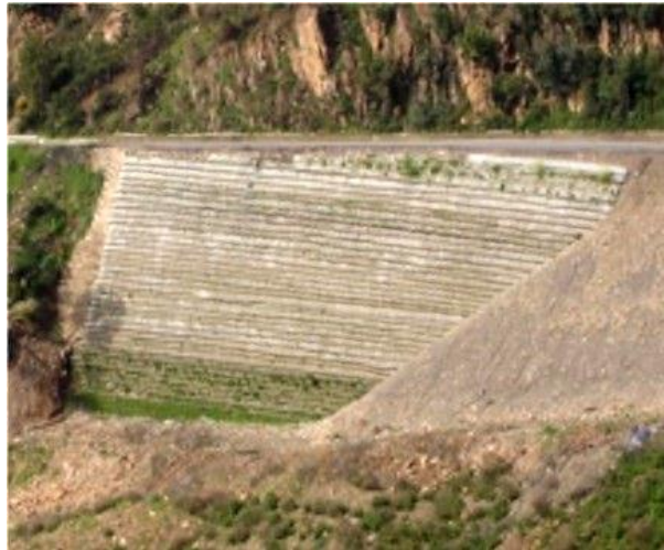
FigureIV.13 : Ouvrage souple, en géotextile CW13, Tifra Bejaia.
