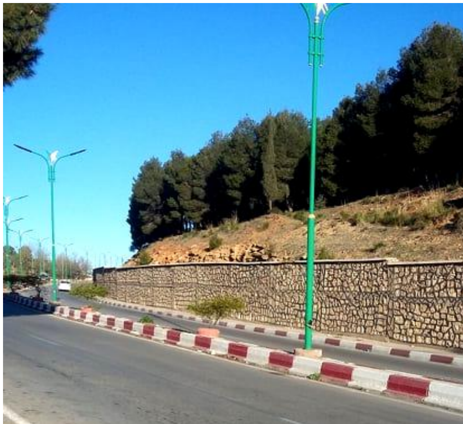
Photo V.4 : Stabilité du talus par un mur en maçonnerie « entrée de la ville de Tiaret »
