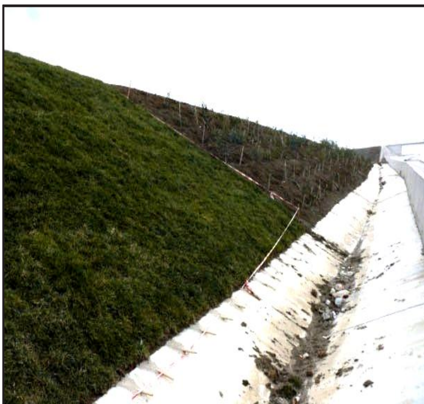
Figure V.8 Les talus marneux après traitement par les géosynthétiques.
