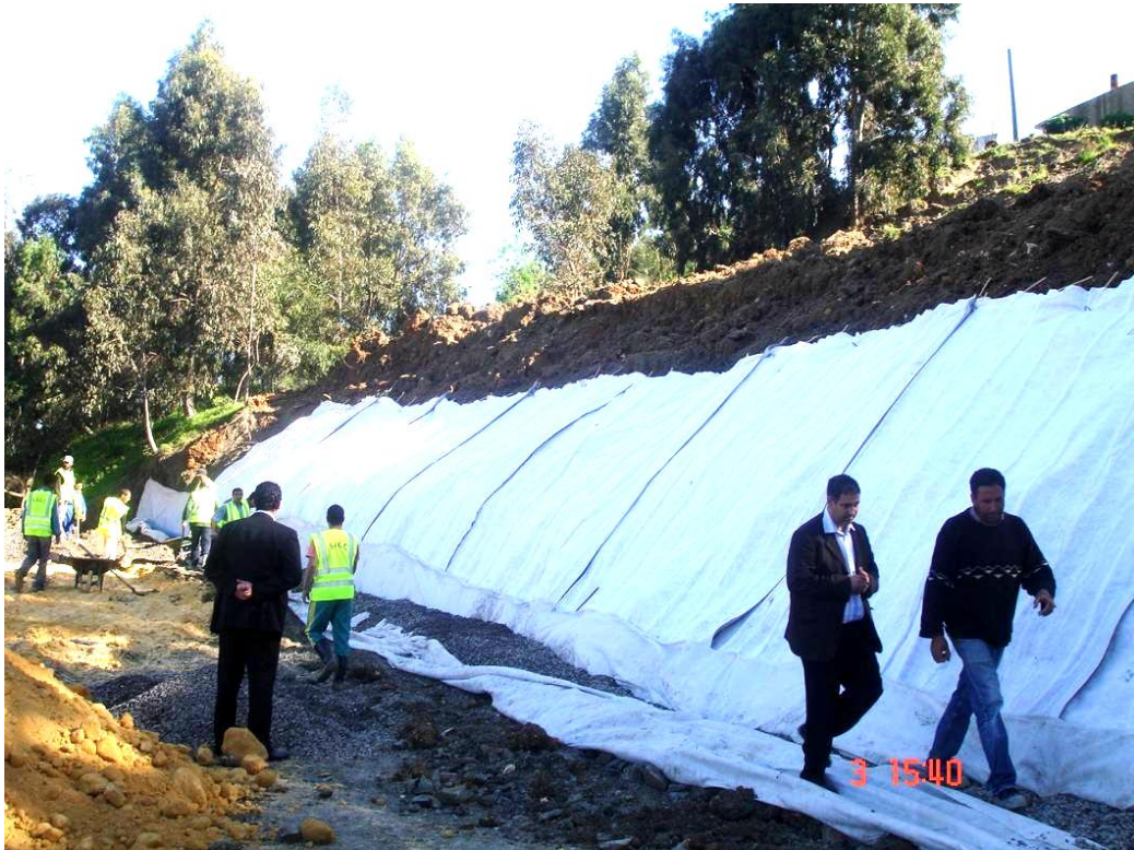
FigureV.16 Mise en œuvre du géocomposite de drainage équipé de mini-drains
