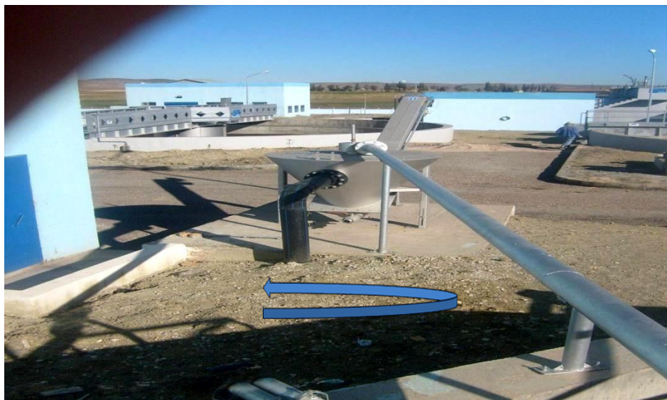
Photo III.10 : Classificateur de sable
