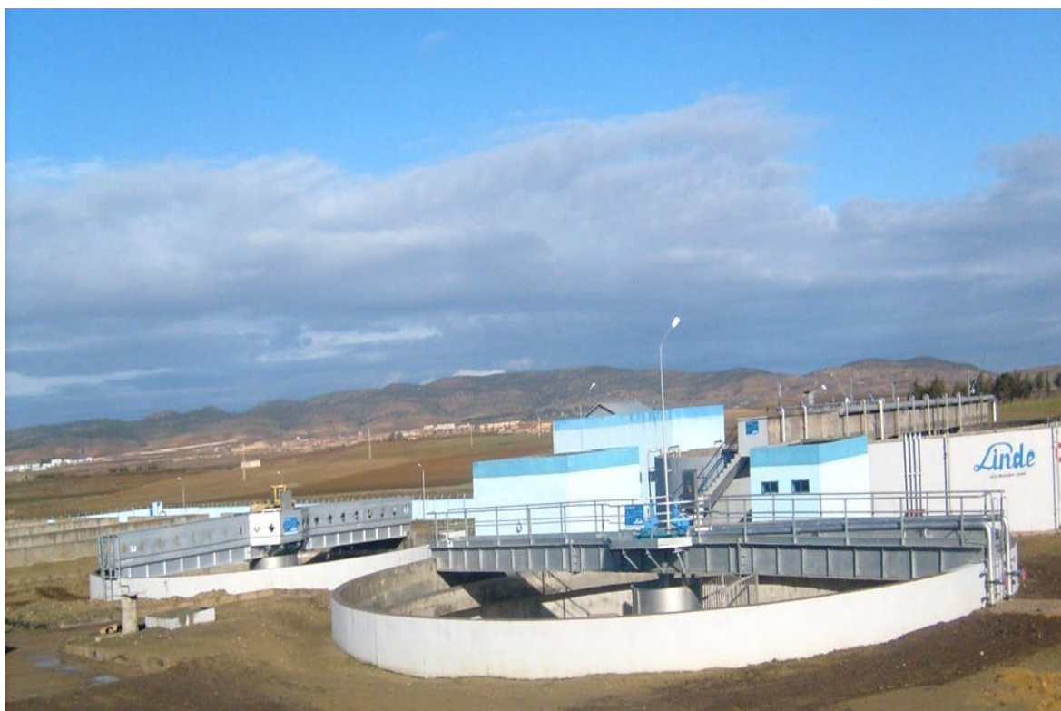
Figure III.13: Vue d'ensemble des épaisseurs I et II de la station de Tiaret
