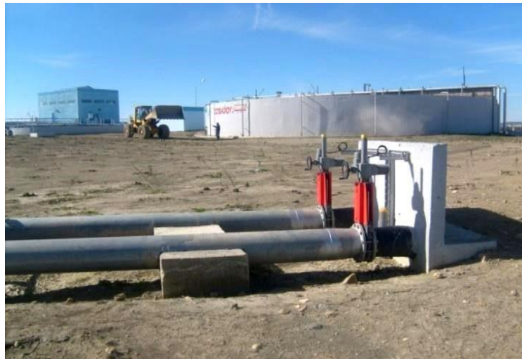
Photo III.19: Conduite d'air
