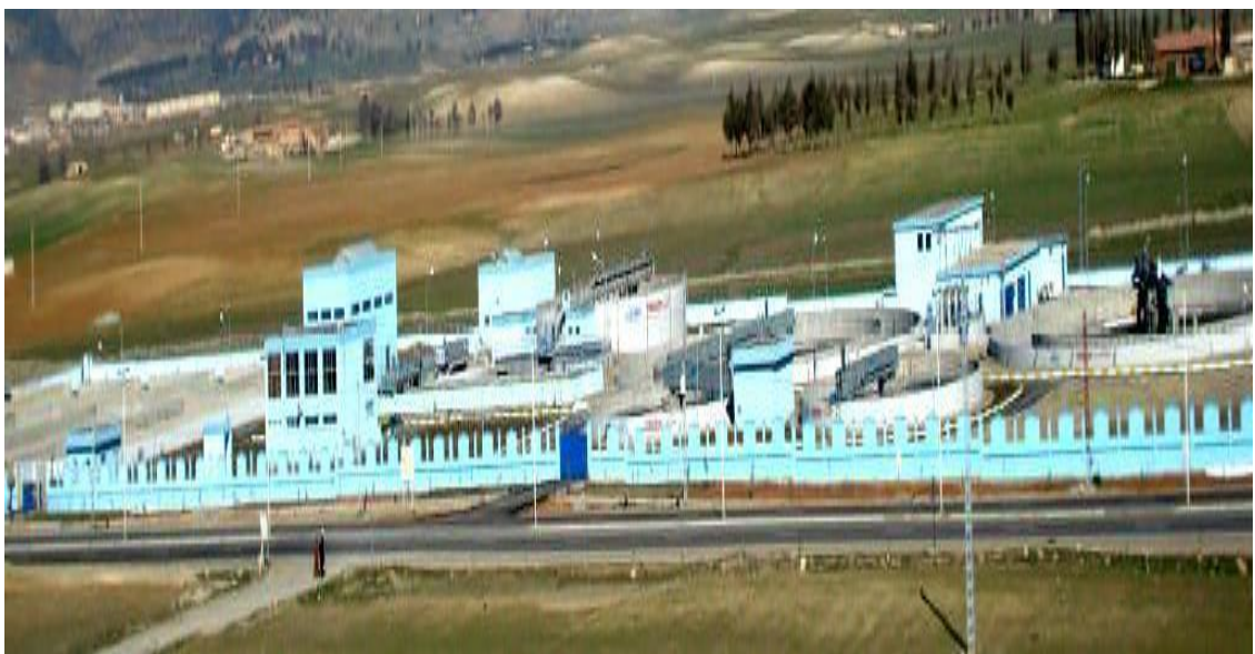
Figure III.7 : Vue d'ensemble de la STEP de Tiaret
