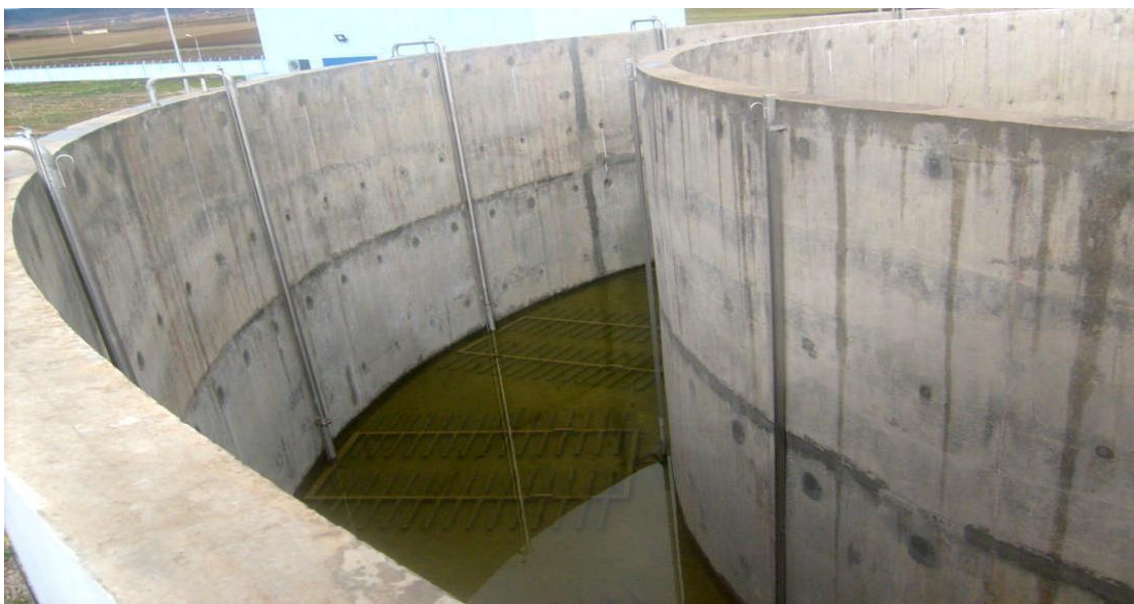
Figure III.14: Vue d'ensemble de digesteur aérobie
