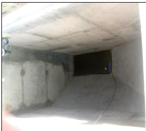
Photo III.8 : Chambre à graisse
