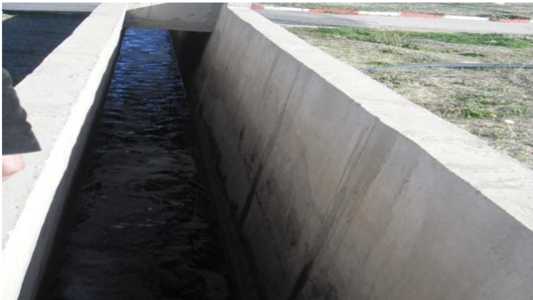
Figure IV.4 . Canal de rejet
