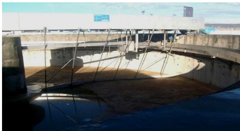
Photo III.11 : Décanteur primaire
