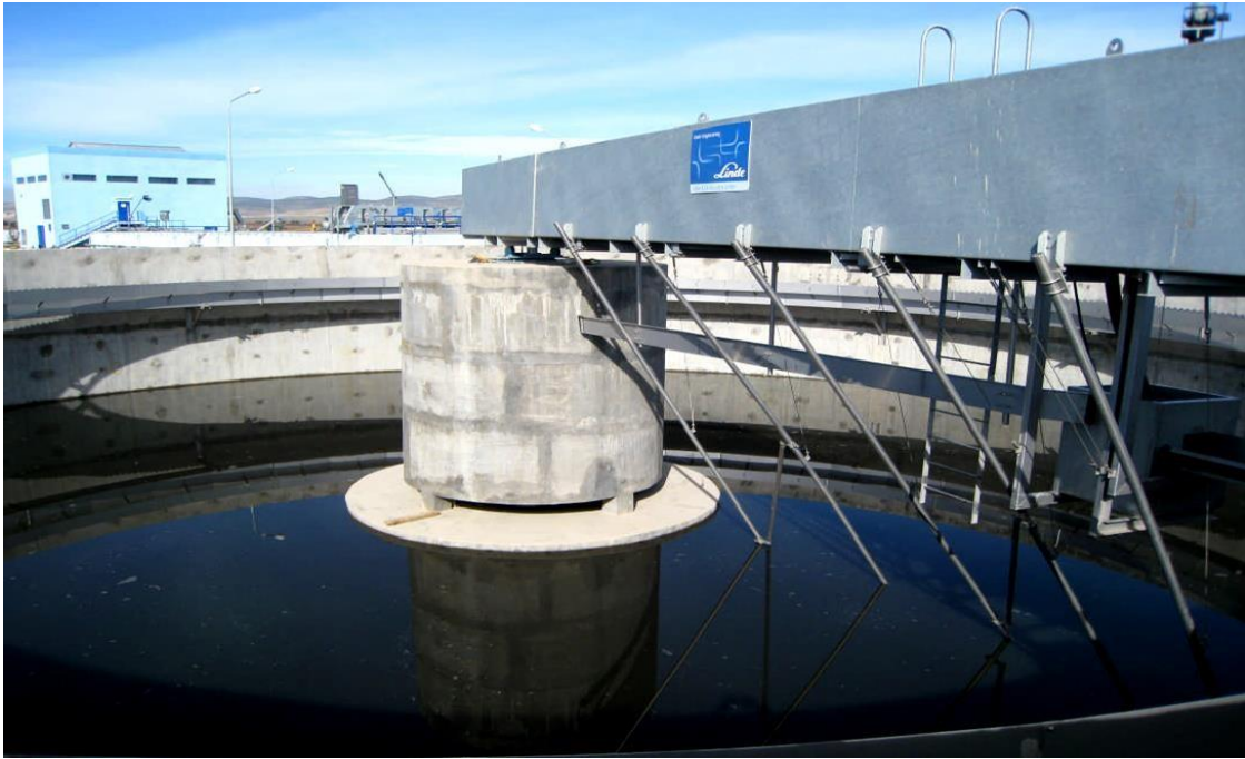
Figure III.11: Vue d'ensemble du bassin de décantation primaire.
