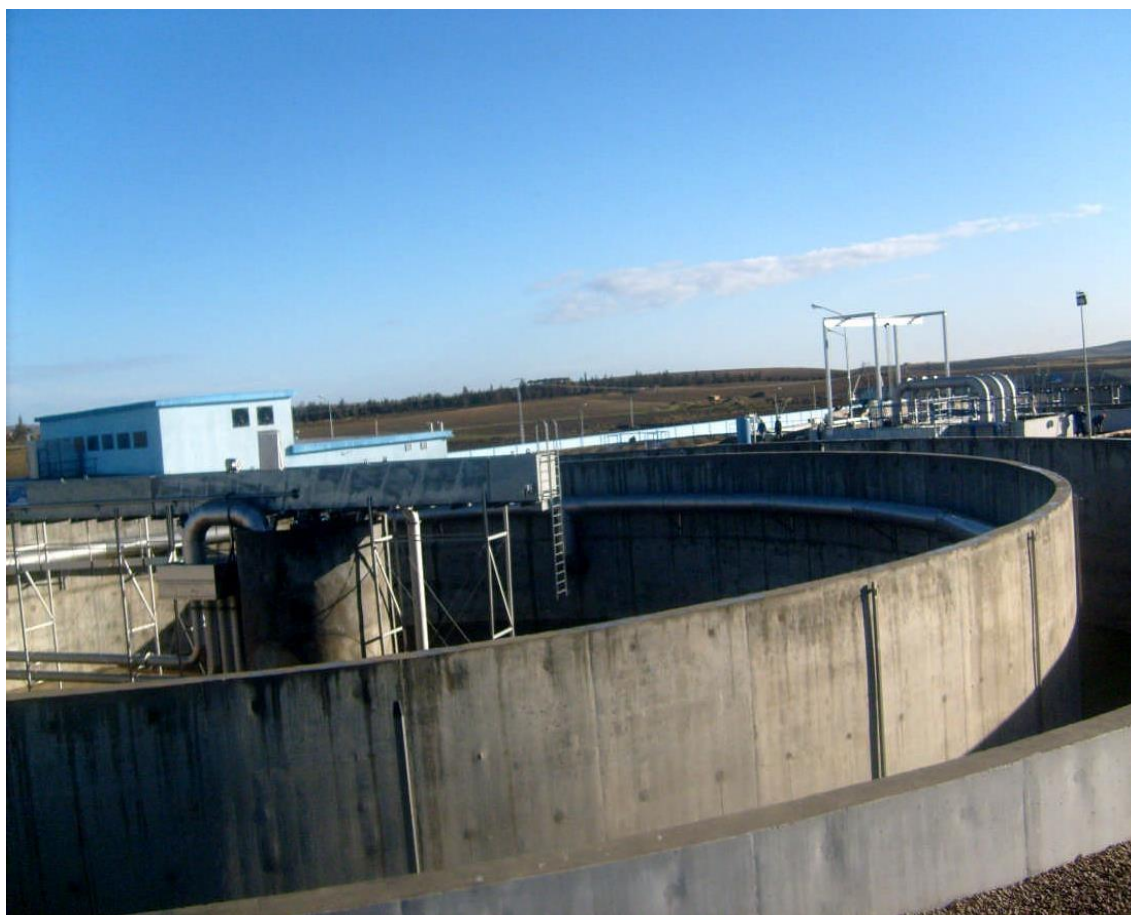
Figure III.12: Vue d'ensemble du bassin combinaison
