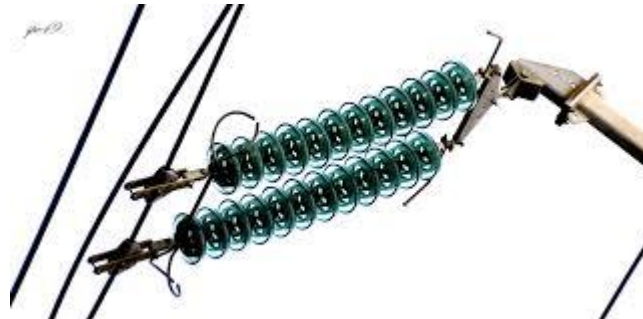
Fig.I.5 : Isolateurs rigides en verre.
