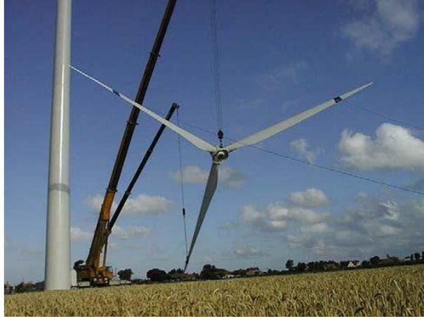
Fig.I. 8 Rotor d'une éolienne en montage.
