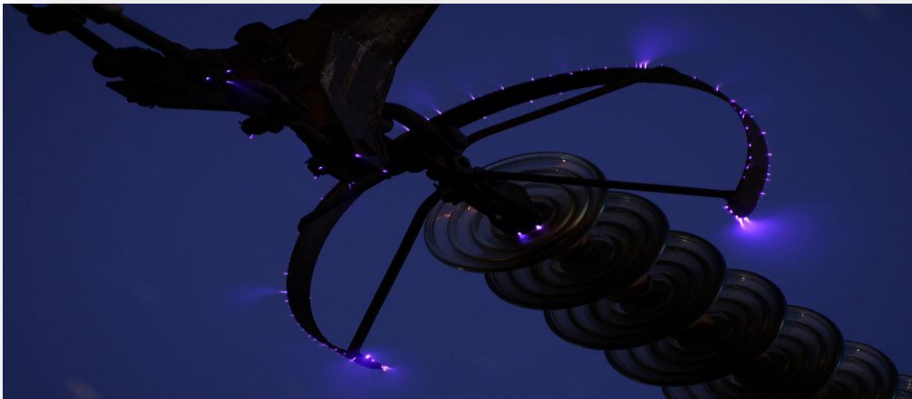
Figure I.11: Effet de couronne sur un éclateur (ligne de 500 kV) ; il correspond à une perte en ligne et à une production d'ozone troposphérique polluant.
