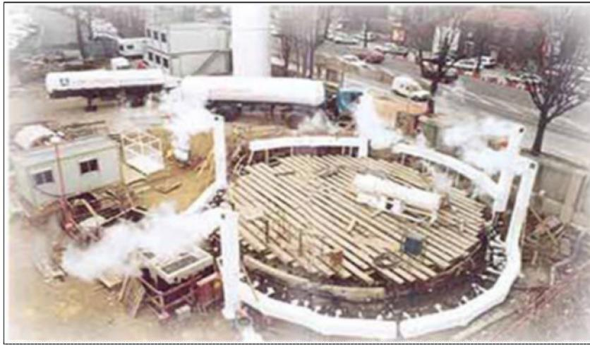
**Figure. 1.11:** Chantier utilisant la congélation du sol
