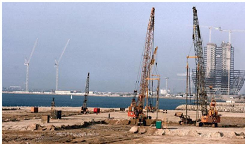
**Figure.1.8:** Procédé du vibrocompactage
