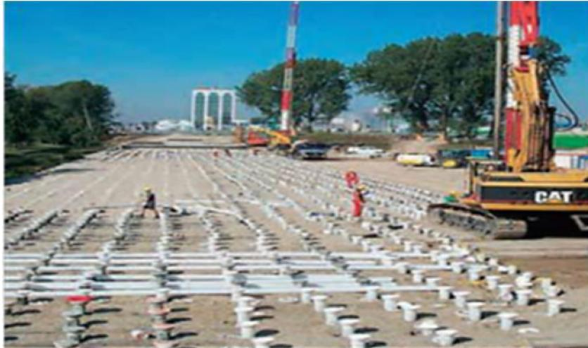
**Figure. 1.10:** Procédé d'installation des drains.
