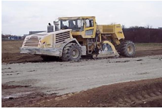
**Figure. 1.13:** Chantier de traitement du sol au ciment
