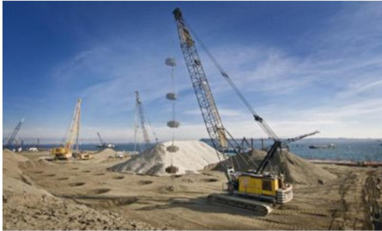
**Figure. 1.7:** Chantier d'un compactage dynamique profond
