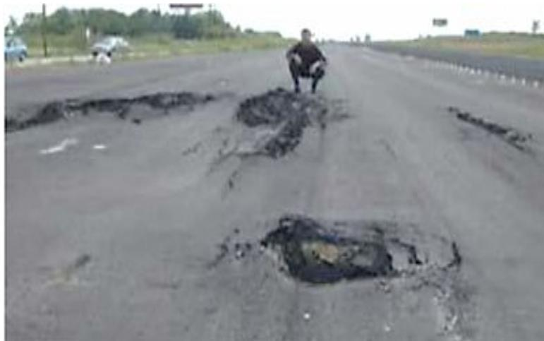
**Figure. 1.5:** Déformation d'une chaussée de sol instable
