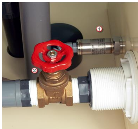
Figure 2. 12: Capteur de pression et Vanne de vidanger
