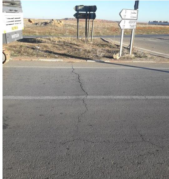
*Fissures longitudinales et transversale formant un faïençage à maille large.*
