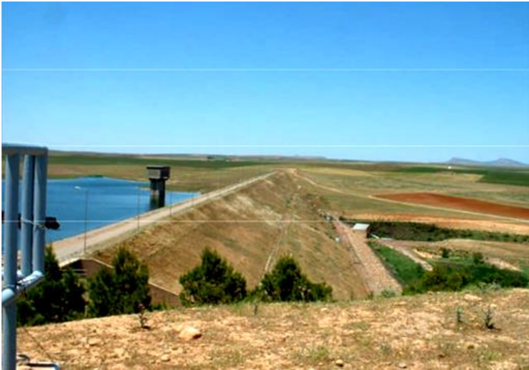
PhotoVI.1 : Barrage de DAHMOUNI
