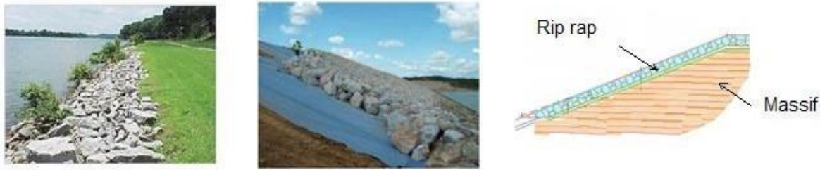
Figure IV.2: Protection amont en enrochements
