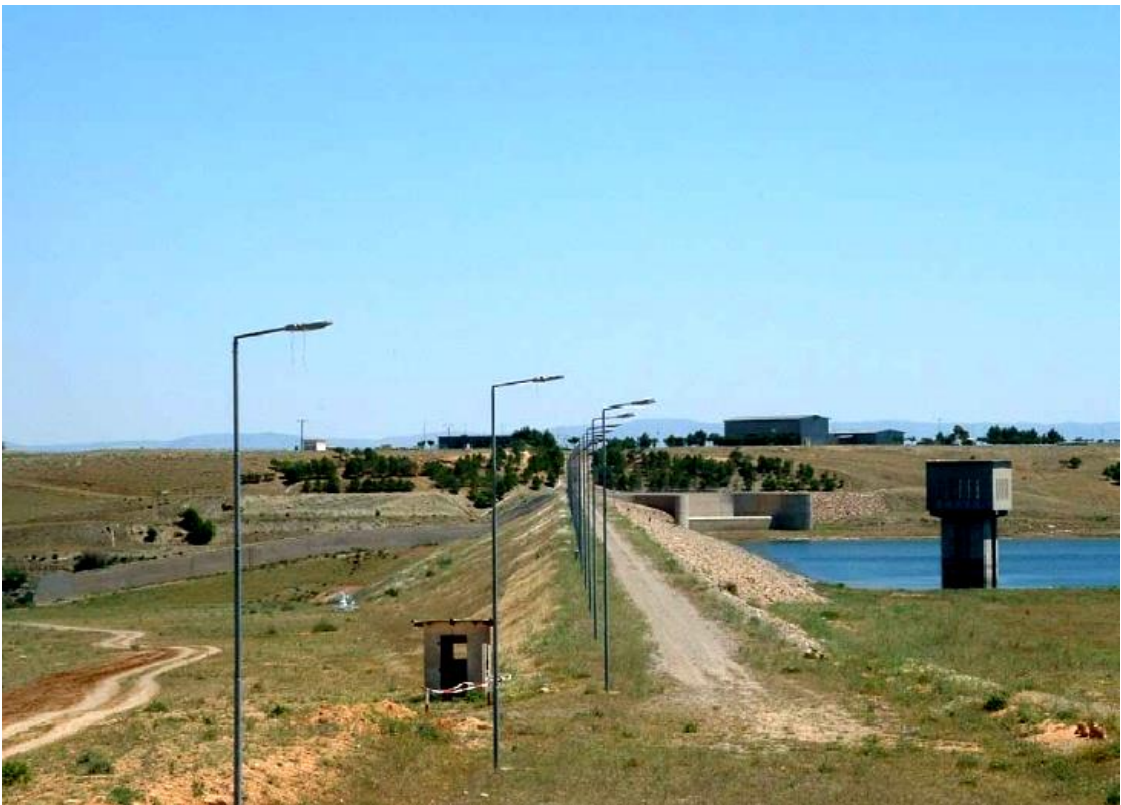
Figure VI.2: Digue du barrage DAHMOUNI (Tiaret)
