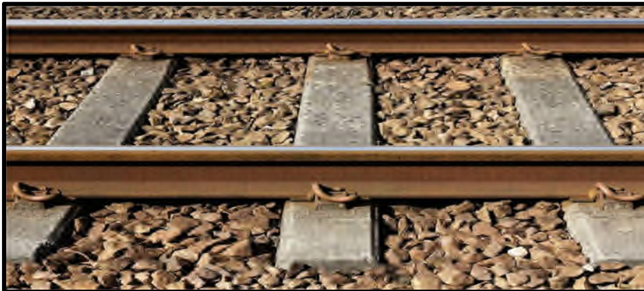
Figure V.1 Le ballast de chemin de fer
