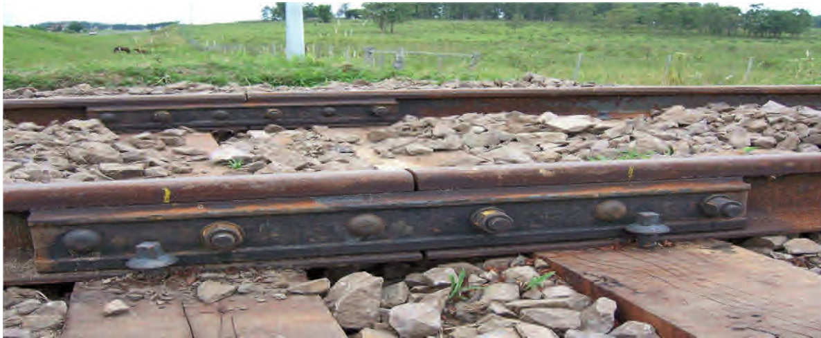
Figure VII.5 : Assemblage du rail par des éclisses
