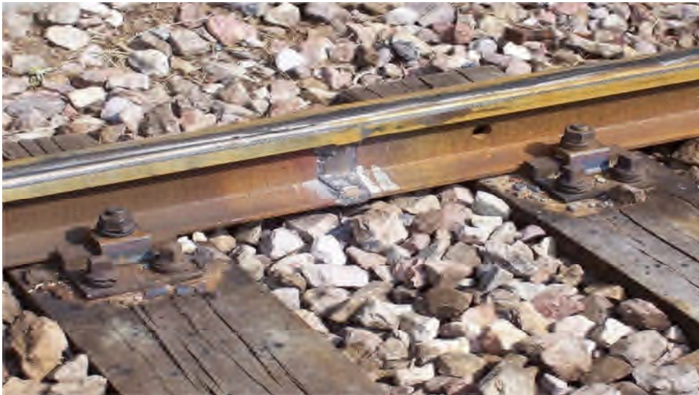
Figure VII.7 : Assemblage des rails par soudure des LRS
