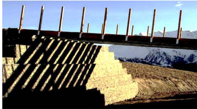
Figure IX.09 : mur de soutènement en gabion
