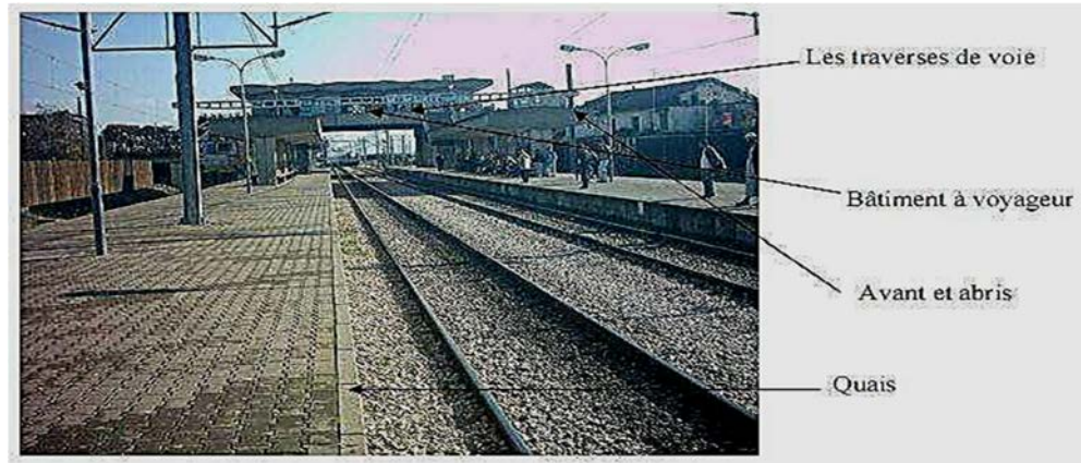
Figure XI.N°03: Equipement de la gare.
