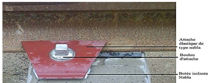
Figure VIII.N°05 : Les éléments d'une attache de type Nabla.
