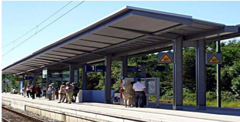
Figure XI.N°02 : Auvents et abris.
