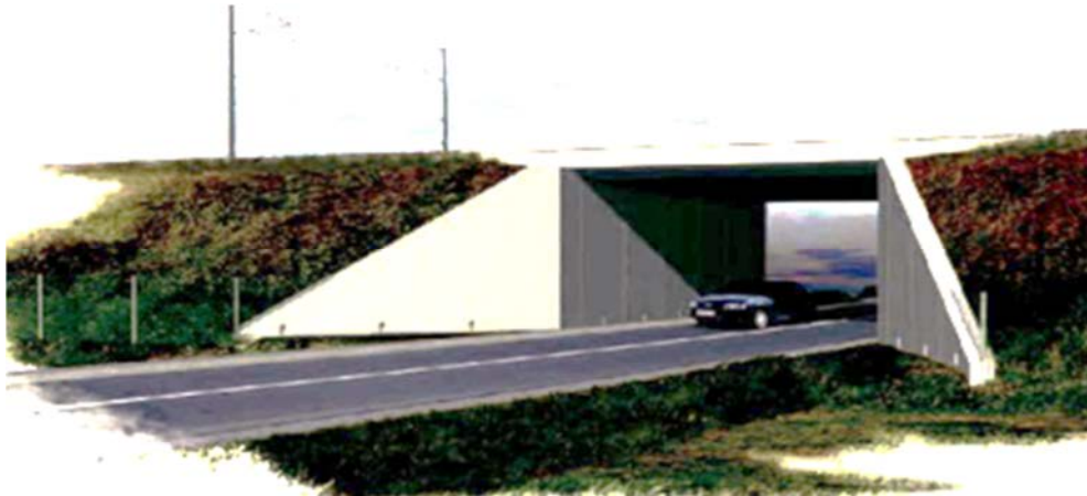
Figure IX .01: Passage supérieur d'un chemin de fer.
