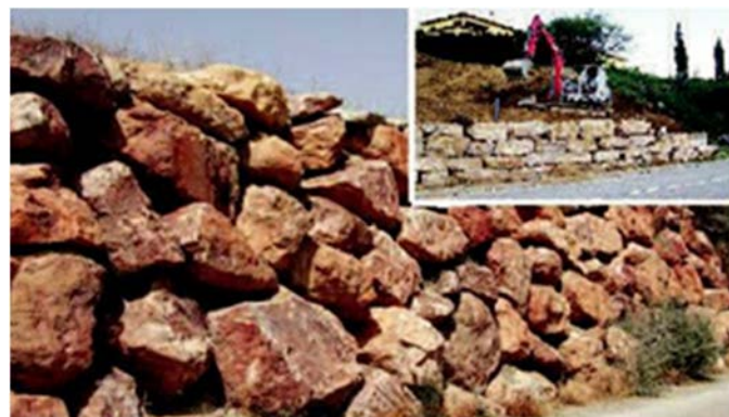
Figure IX.11 : enrochement des pieds des talus
