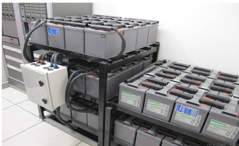
Figure 2.10 : Installation de batteries électriques
