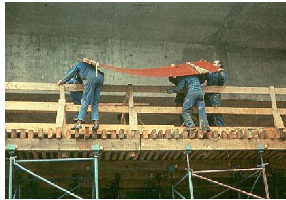
Figure I. 14: renforcement par collage de plats métalliques
