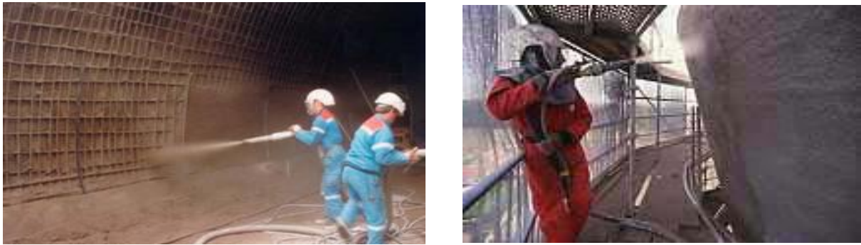
Figure I. 11: Renforcement au moyen de béton projeté
