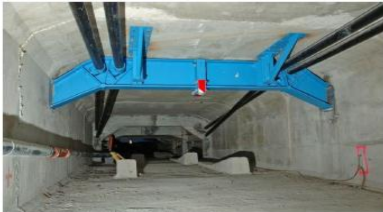
Figure I. 13: précontrainte additionnelle
