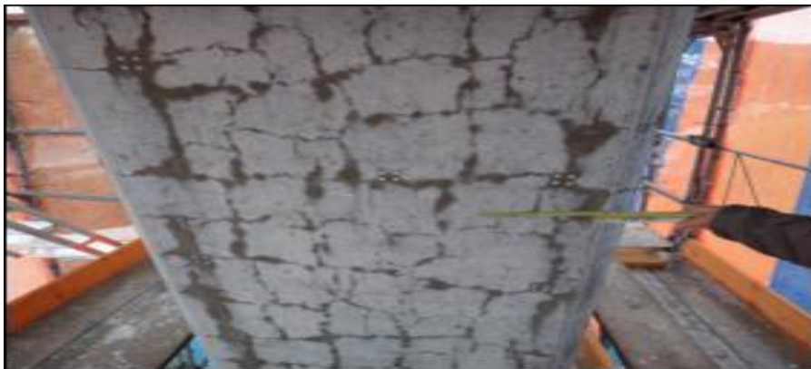
Figure I. 3: Epaufrures dues à la l'alcali-réaction
