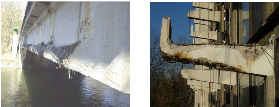
Figure I. 1 : Structures atteintes par la carbonatation
