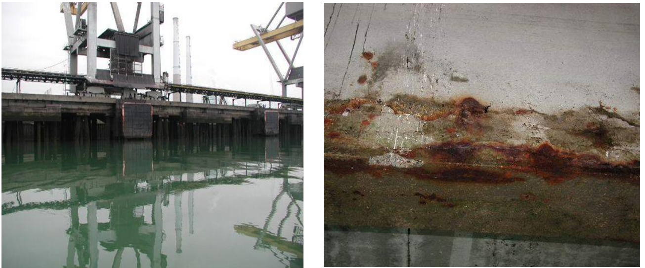
Figure I. 4 : Poutre située en bord de mer sous de l'agression des chlorures
