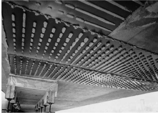
Figure I. 14: renforcement par collage de plats métalliques
