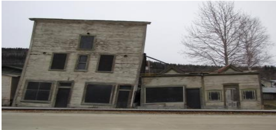
Figure I. 7 : Tassement différentiel
