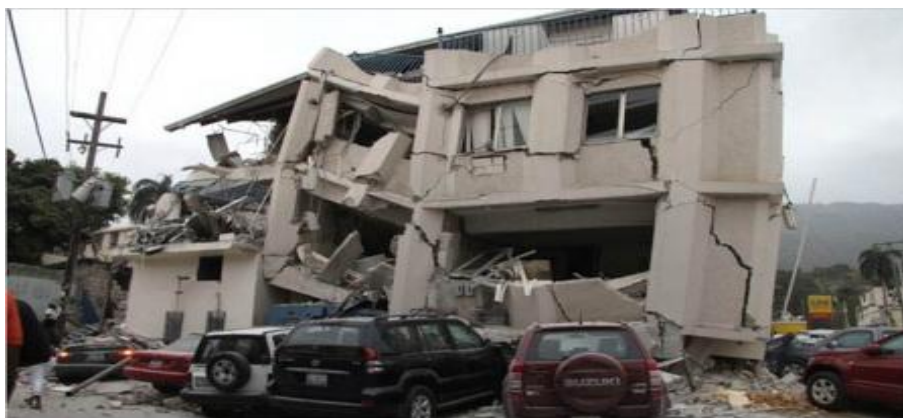
Figure I. 8 : Désordres dus au séisme
