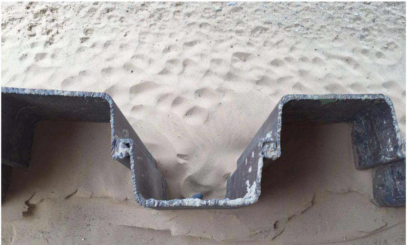
Figure I. 21 : exemple de Palplanche Larsen (Photo Prise par LARIBI Achraf RN23 Oued
