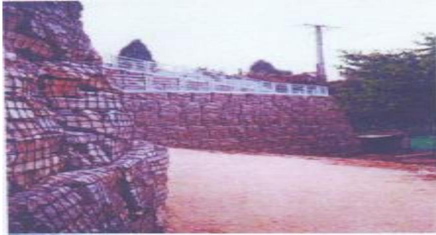
*Figure I. 12: Mur de soutènement en gabions*
