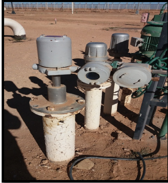
FigureIII-5 Pose du transmetteur sur bride 6''
