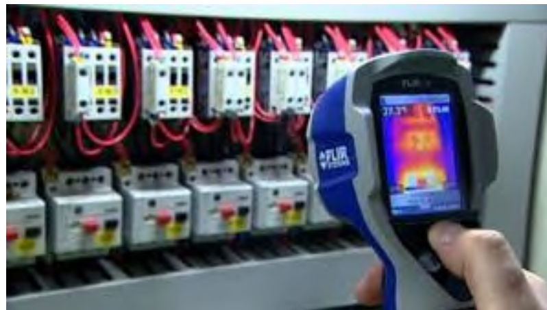
Figure I.3. Location caméra thermique pour Maintenance industrielle
