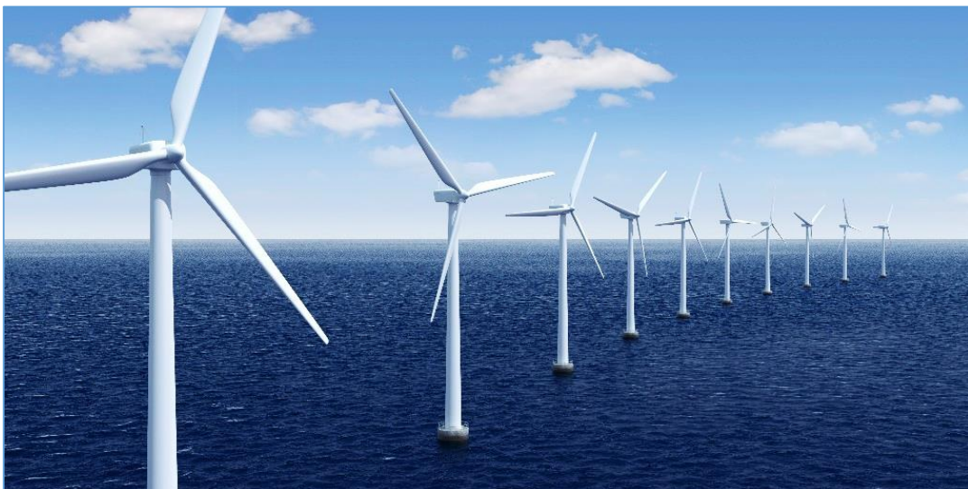
Fig.I.7 : Eolienne à axe horizontal
