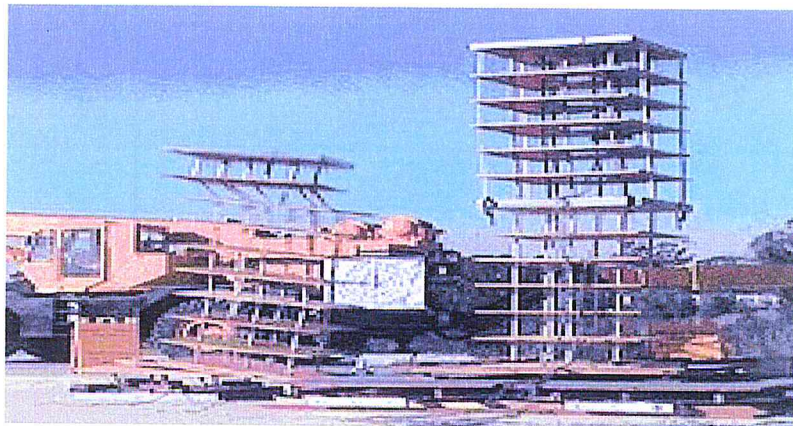
Figure II.1 :réalisation d'une structure.
