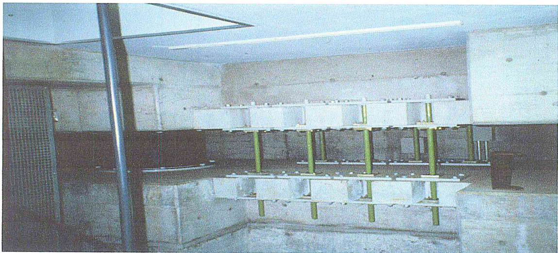
Figure I.23 : isolateur à déformation (à gauche) et groupe d'amortisseurs hystérétiques (barres d'acier doux, à droite).
