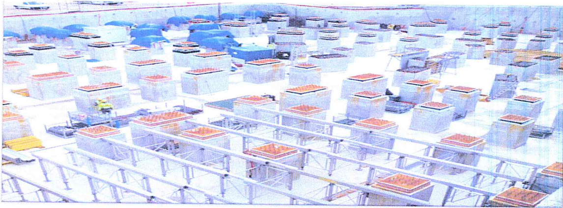
Figure I. 1 : Mise en place des isolateurs sur les massifs d'une structure.
