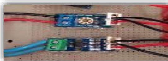
Figure.3.21 : mesure de courant et tension de la charge AC.
