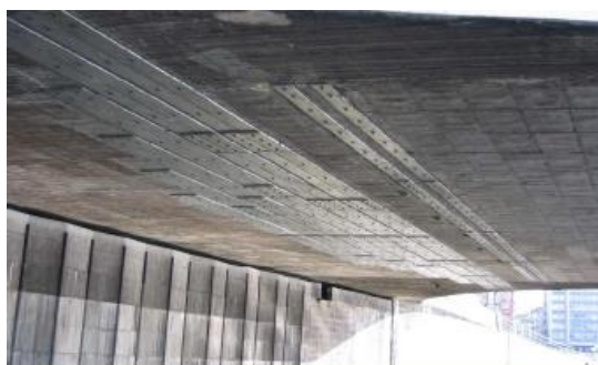
Figure I. 5: Renforcement par plats métalliques
