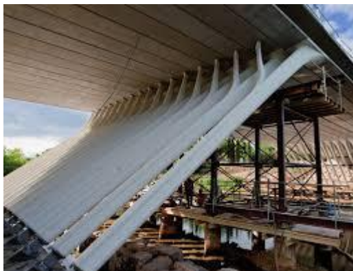
Figure I. 4: Renforcement par précontrainte additionnelles
