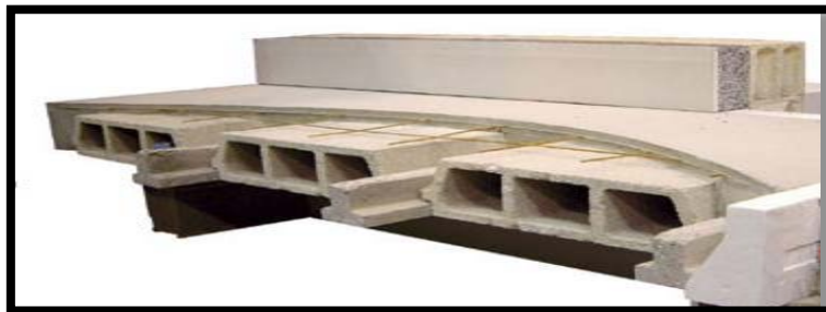
Figure III.4 : Plancher à corps creux.
