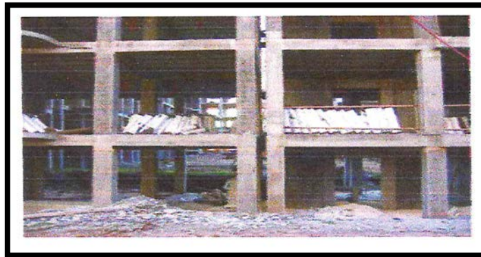
Figure III.3 : Portiques auto stable (poteaux- poutres).
