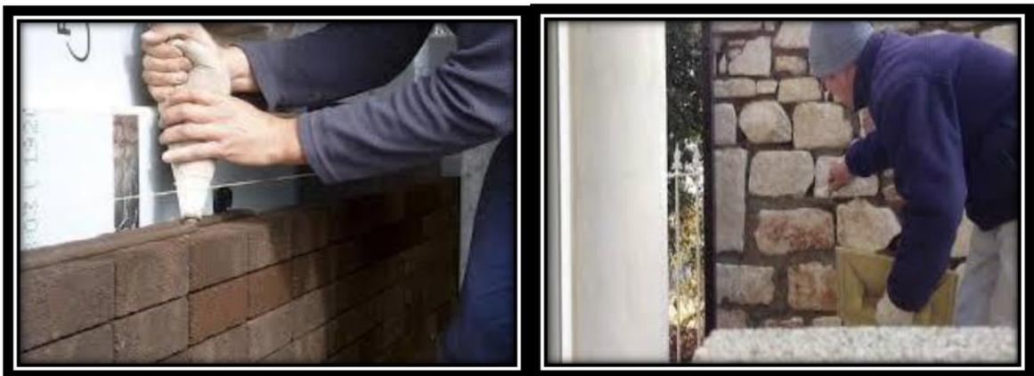
**Figure I.7 : Les joints de maçonnerie [20]**
