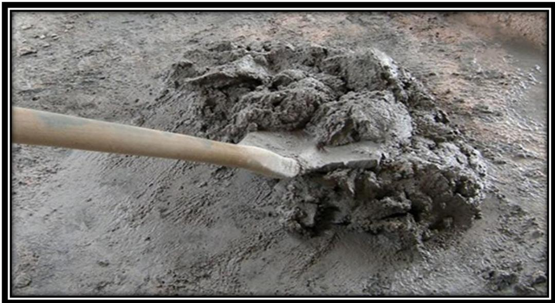
**Figure I.1 : Mélange de mortier**
