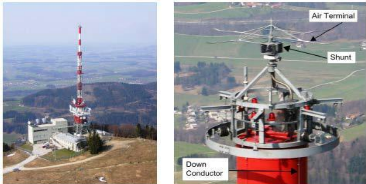
Figure I.12 : Position du capteur de courant de foudre sur la tour Gaisberg [22]
