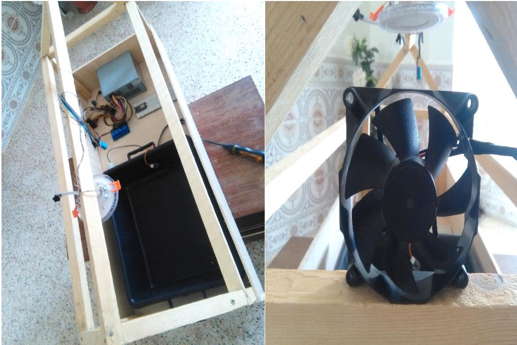
Image 18: Installation des dispositifs électriques
