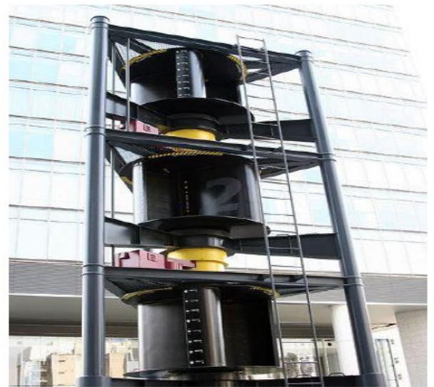
Figure I.5 Photographie d'une éolienne Savanious [4]
