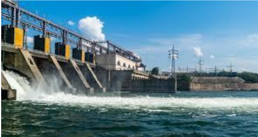
Fig-I.7 : Centrale hydraulique [Web-6]
