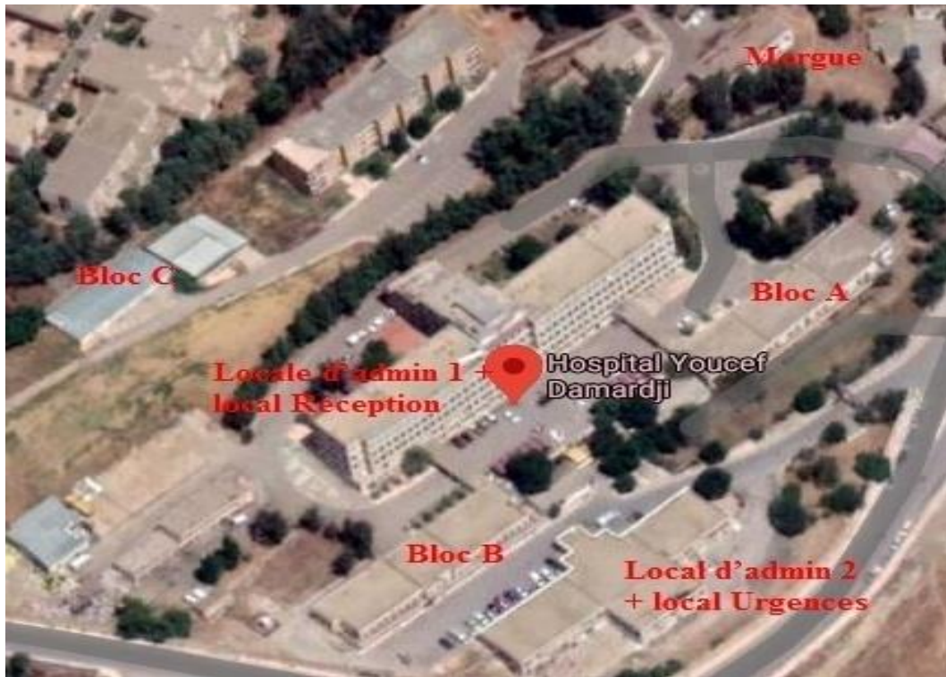
Figure III.4. Vue 2 Hôpital Youcef Demerdji Satellite Google Earth
