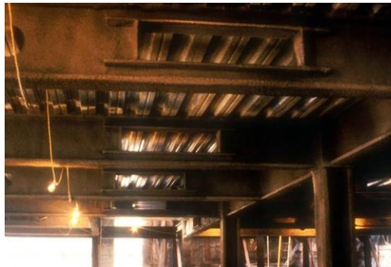
**Figure. 2** Photographie des poutres ajourées renforcées.
