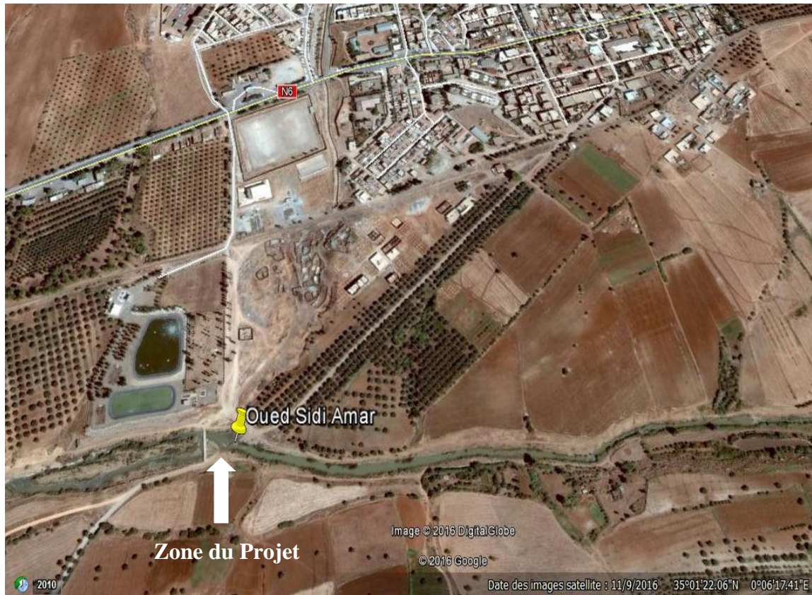
Figure I-3 Vue du site d'implantation de l'ouvrage (Source : Google Earth 2017)
