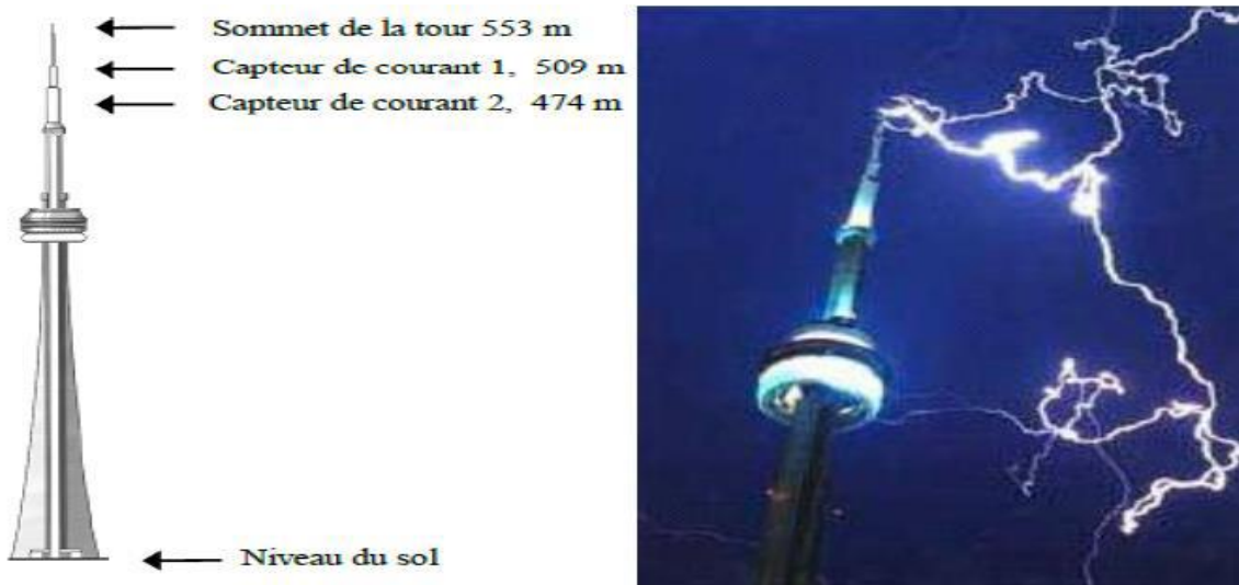
Figure I. 6: Exemple de mesure de courant de foudre en utilisant une tour instrumentée. Tour CN à Toronto au Canada. [15]
