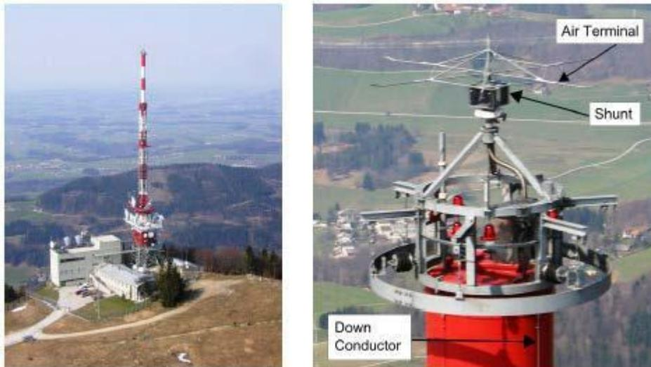
Figure I.18 Position du capteur de courant de foudre sur la tour Gaisberg [24]
