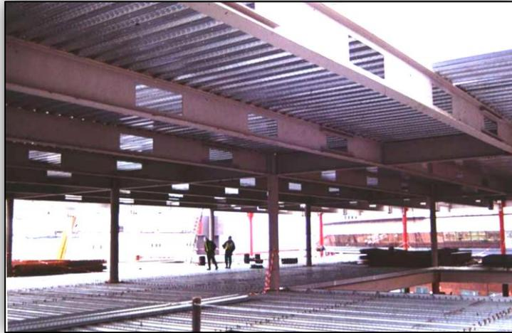
☞ *Figure 1.2.* Ouvertures rectangulaires isolées dans une poutre mixte
